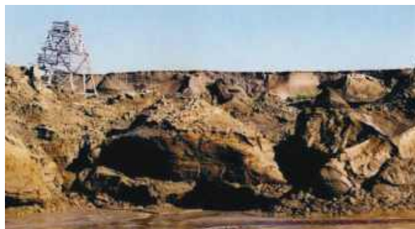
Рис. 3. Разрушение навигационного знака на берегу арктического моря в Северо-Восточной Якутии. Фото М.Н. Григорьева
