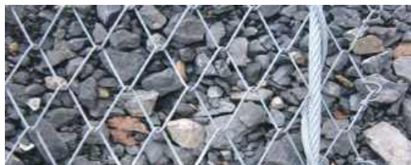
Рис. 10. Укрепление бортов карьера сетчатой завесой. Фото В.И. Кочкарева
