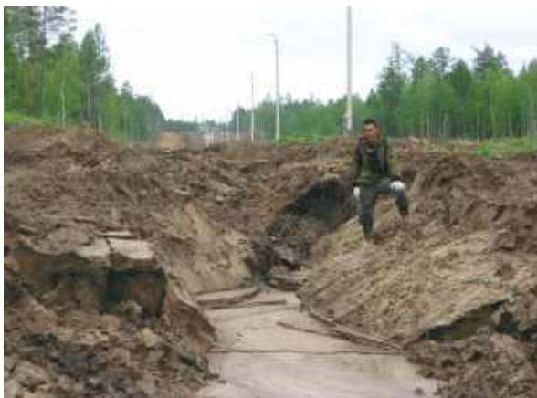
Рис. 11. Термоэрозионный провал в Южной Якутии. Фото И.В. Дорофеева
