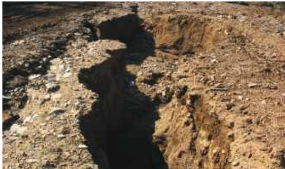
Рис. 8. Морозобойная трещина в теле насыпи. Южная Якутия. Фото С.И. Серикова
